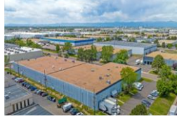
محطة الصناعة في جنوب فلوريدا ودينفر
